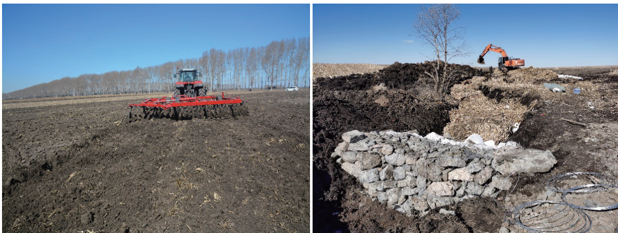
图 6-3 黑土地秸秆填埋侵蚀沟修复技术
